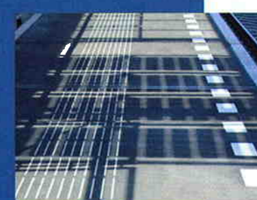
Schaduwwerking op het stationperron door de zonnepanelen
