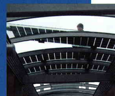
Buigen van de zonnepanelen in het werk
